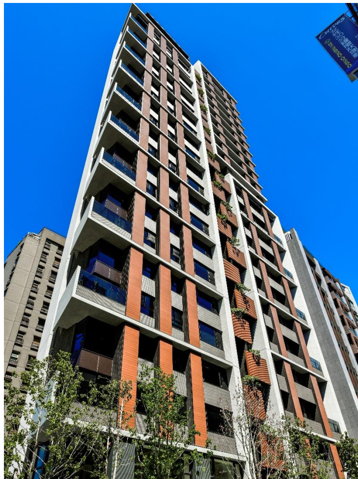
外牆建材鋁包版、石材、日本進口磚→高
