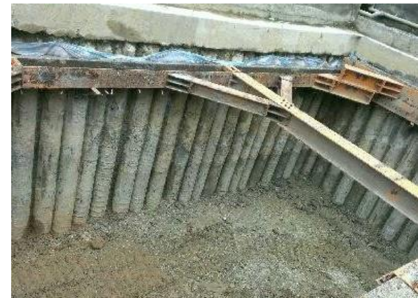
預置樁完成開挖狀況
