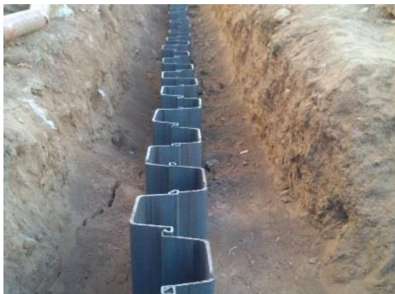
鋼板樁打設完成
