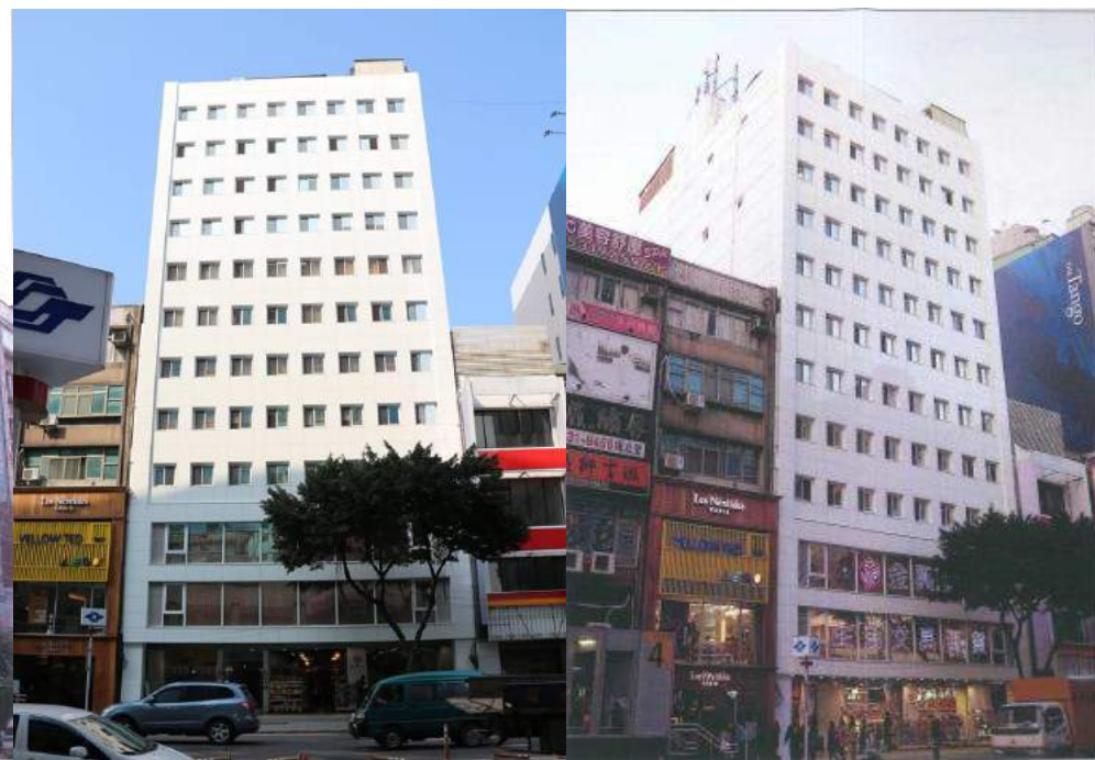
▼更新後建築物立面全貌
