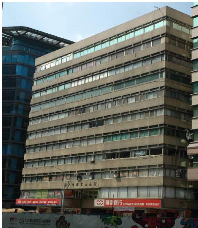
▼更新前建築物立面全貌
