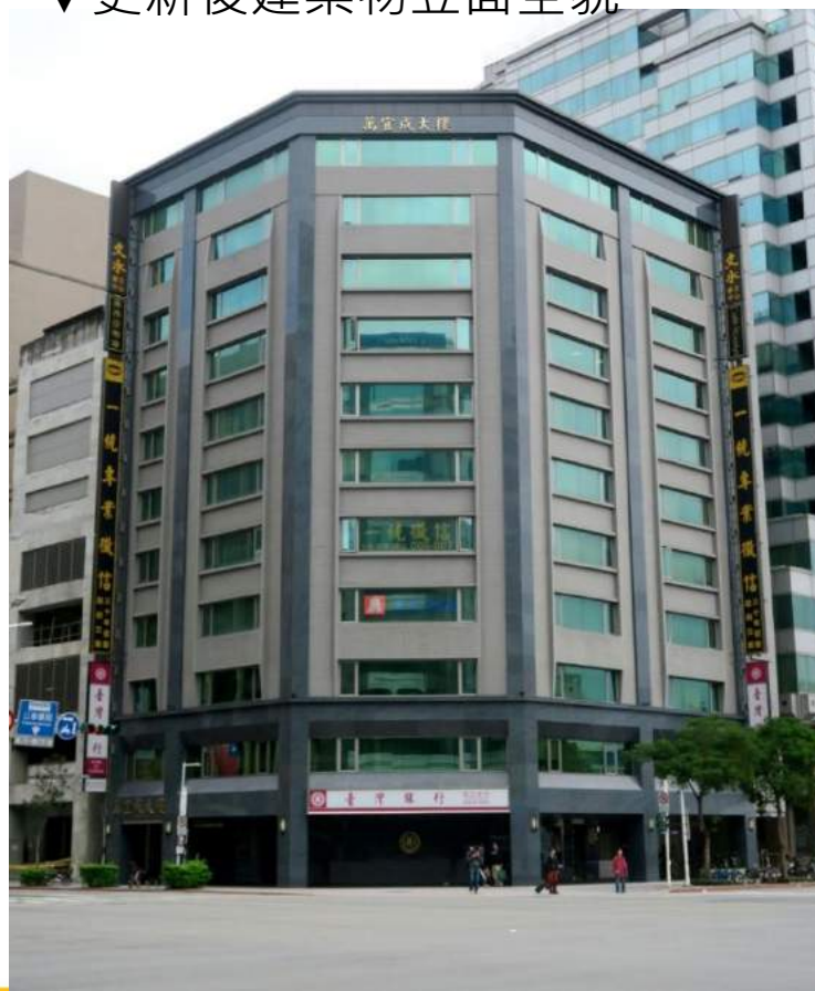
▼更新後建築物立面全貌
