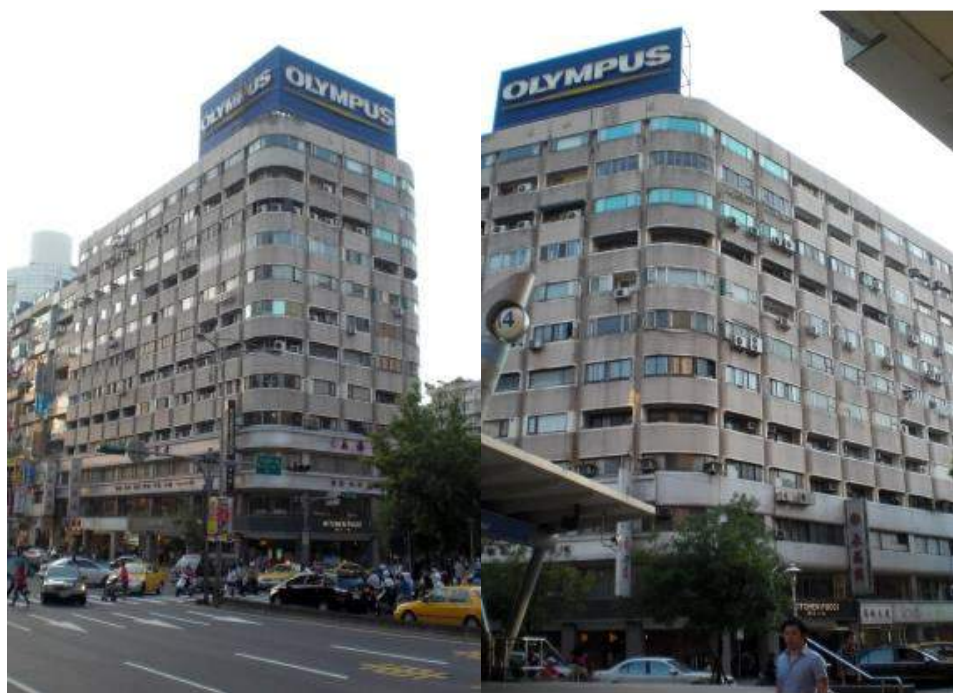
▼更新前建築物立面全貌
