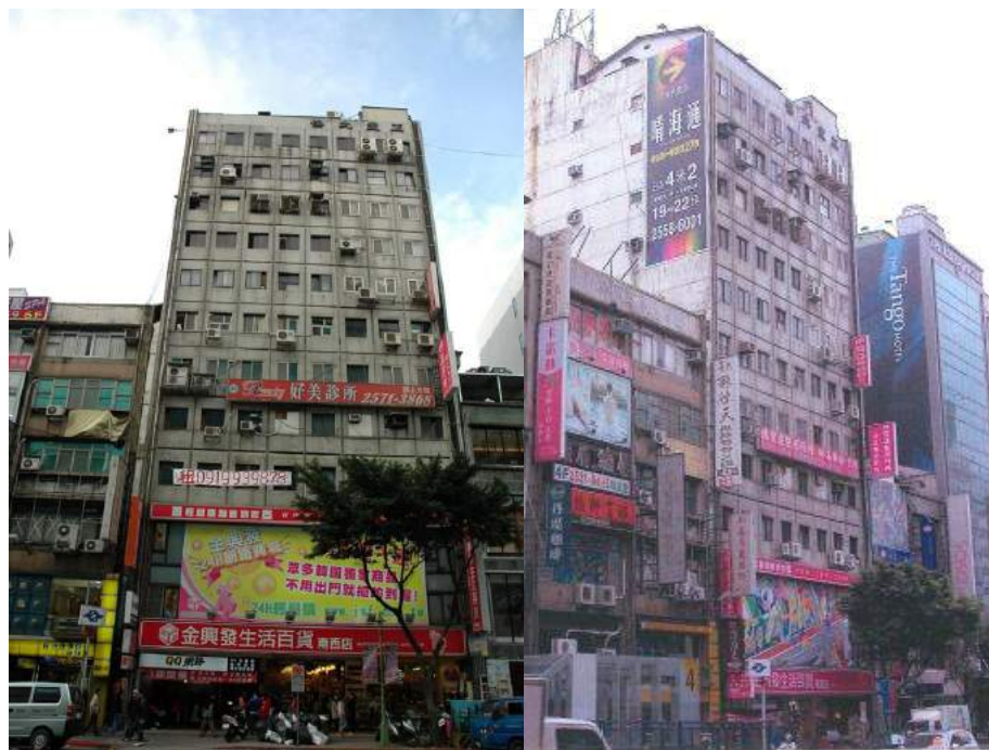
▼更新前建築物立面全貌
