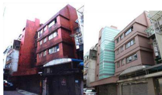
▲更新前建築物立面全貌
