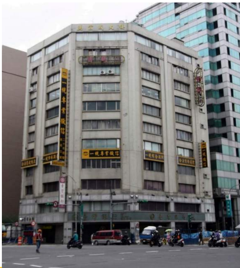
▼更新前建築物立面全貌
