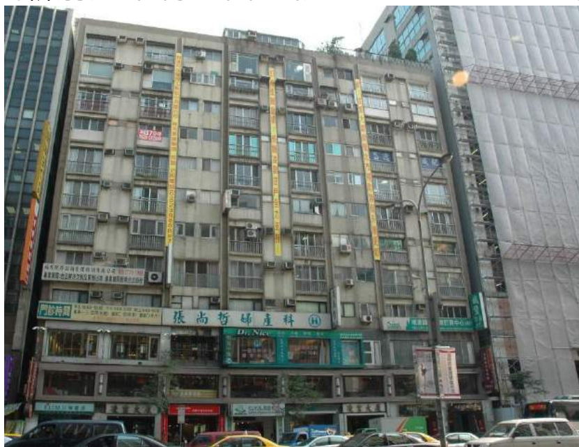
▼更新前建築物立面全貌
