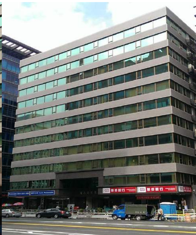
▼更新後建築物立面全貌
