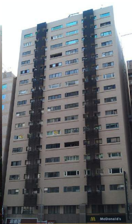
▼更新後建築物立面全貌
