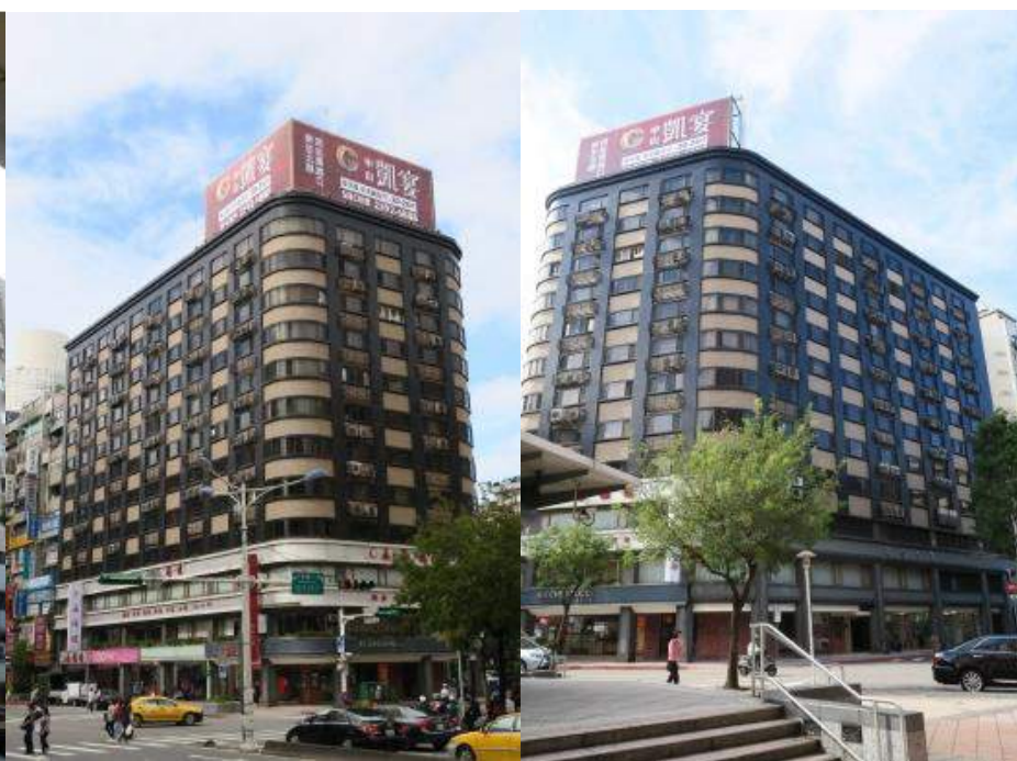
▼更新後建築物立面全貌
