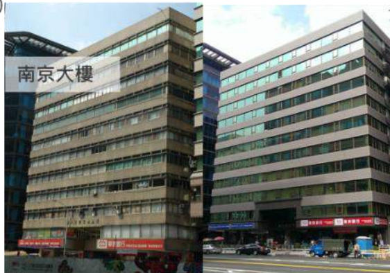
▲更新前建築物立面全貌
