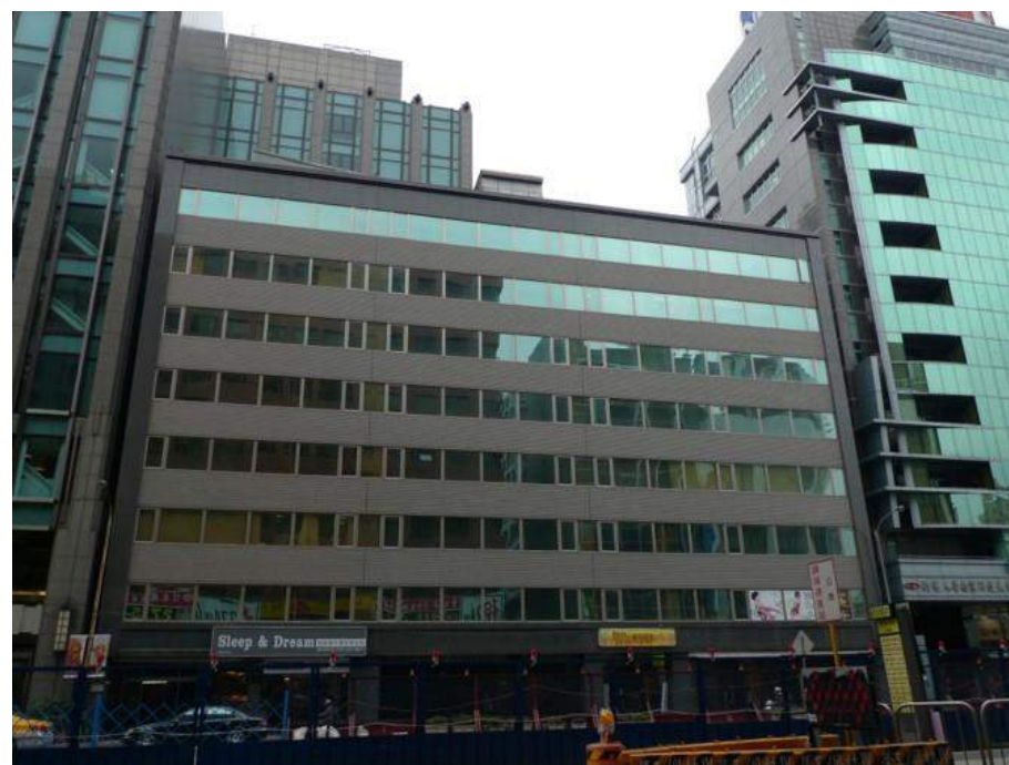
▼更新後建築物立面全貌
