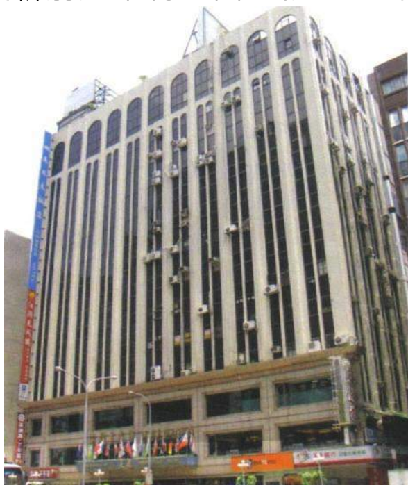
▼更新前建築物立面全貌
