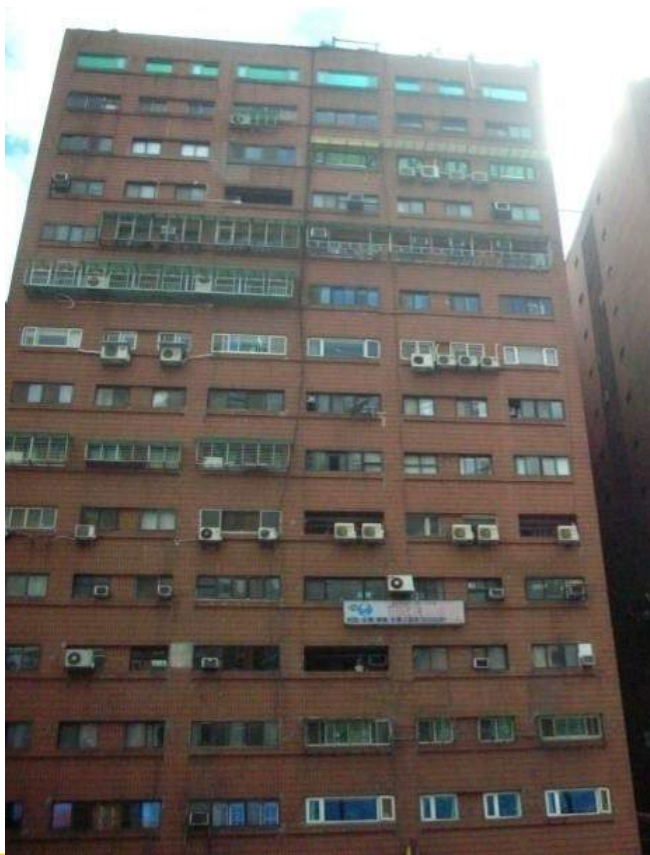
▼更新前建築物立面全貌
