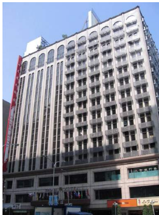
▼更新後建築物立面全貌
