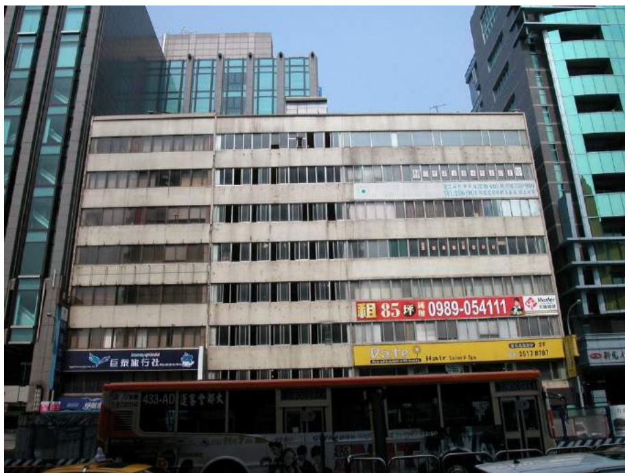
▼更新前建築物立面全貌
