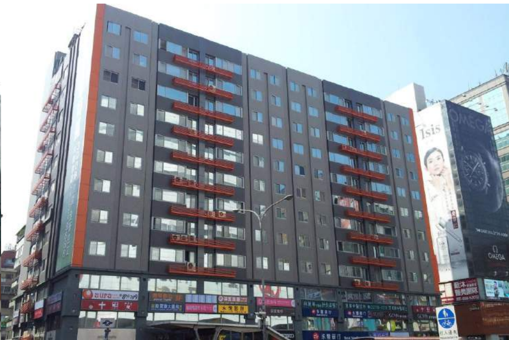
▼更新後建築物立面全貌
