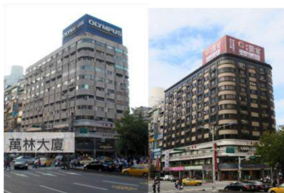
▲更新前建築物立面全貌
