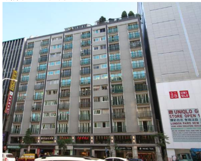
▼更新後建築物立面全貌
