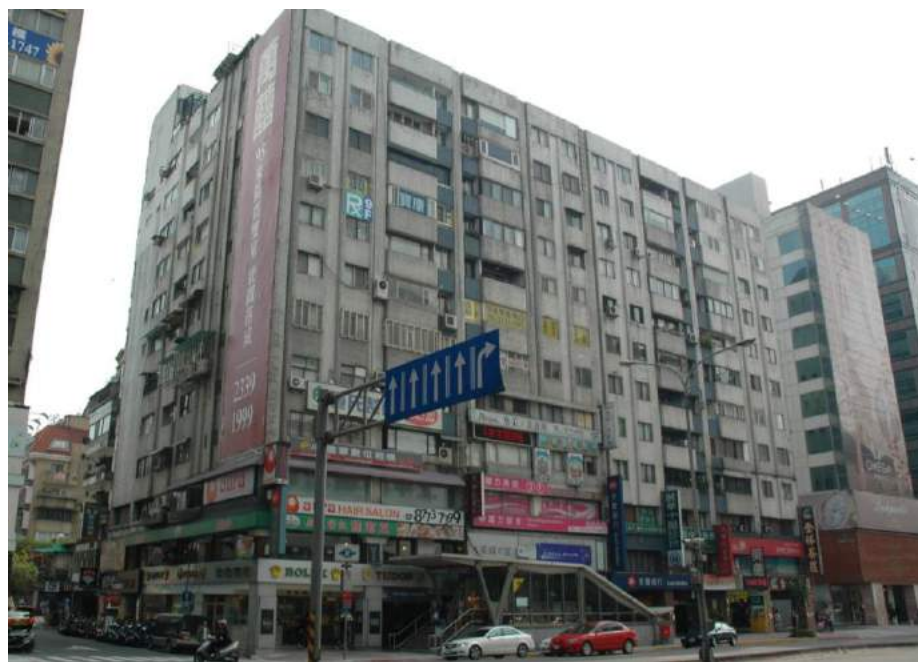
▼更新前建築物立面全貌
