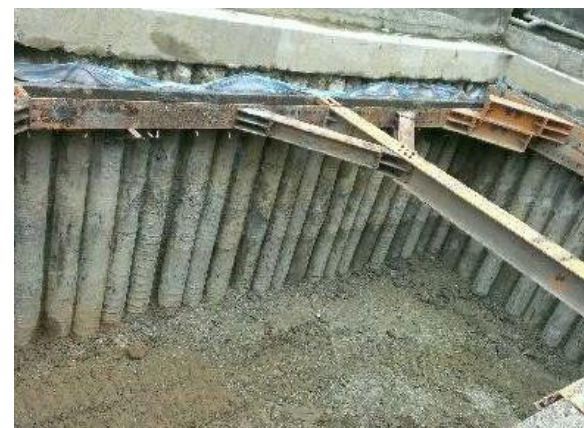
預置樁完成開挖狀況
