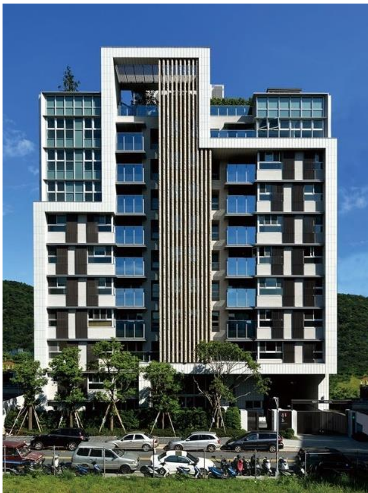
外牆多層次：磁磚、鋁包板、石材格 柵、金屬隔柵→ 高
