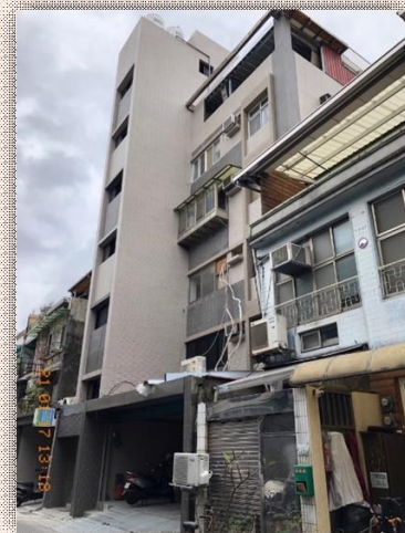
▲更新後建築物立面全貌
