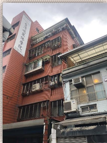
▲更新前建築物立面全貌
