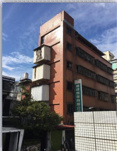
▲更新前建築物立面全貌
