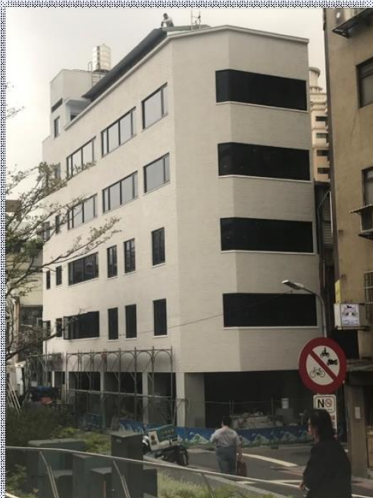
▲更新後建築物立面全貌
